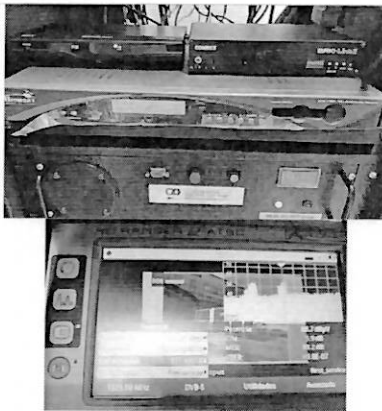
Se revisa los niveles de recepción de señal y se configura decodificador queda optima la señal.
