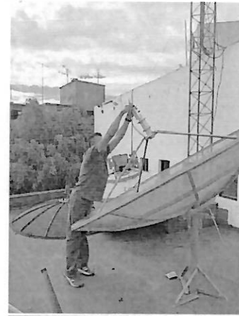
Cambio de polaridad del LNB
